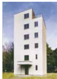
ツーバイフォー6階建て実大実験棟
