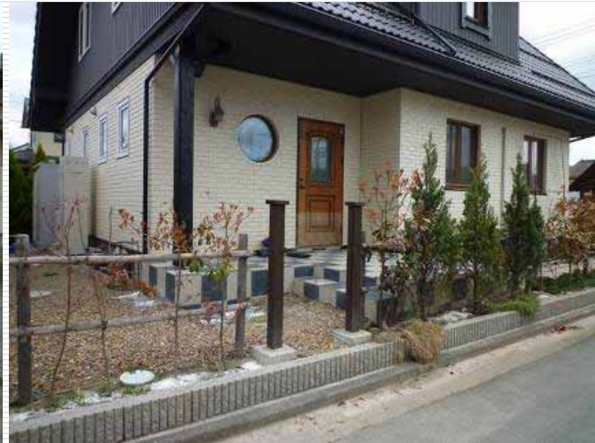
外観はほとんど解らないが、木製玄関ドアに浸水の痕跡が伺える。
