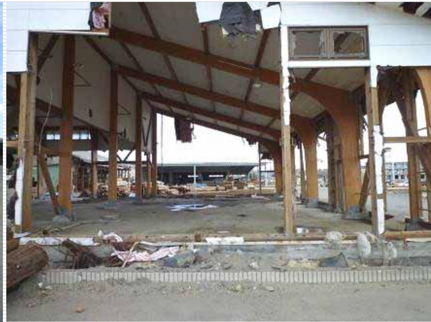
津波が通り抜けてスケルトンは残存
