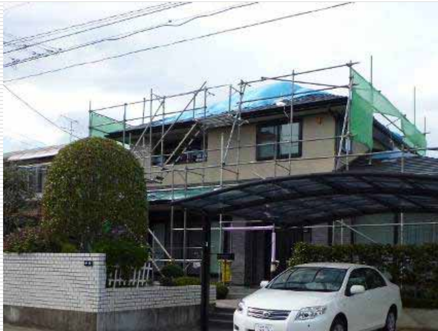
屋根瓦の落下のため、足場を設置して工事中
