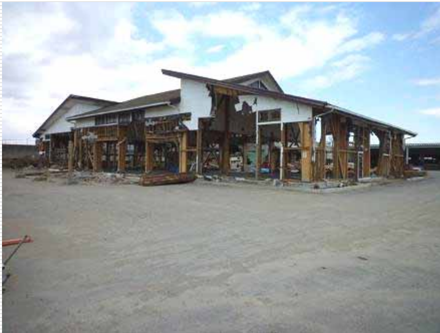
集成材による工場建築物残存状況
