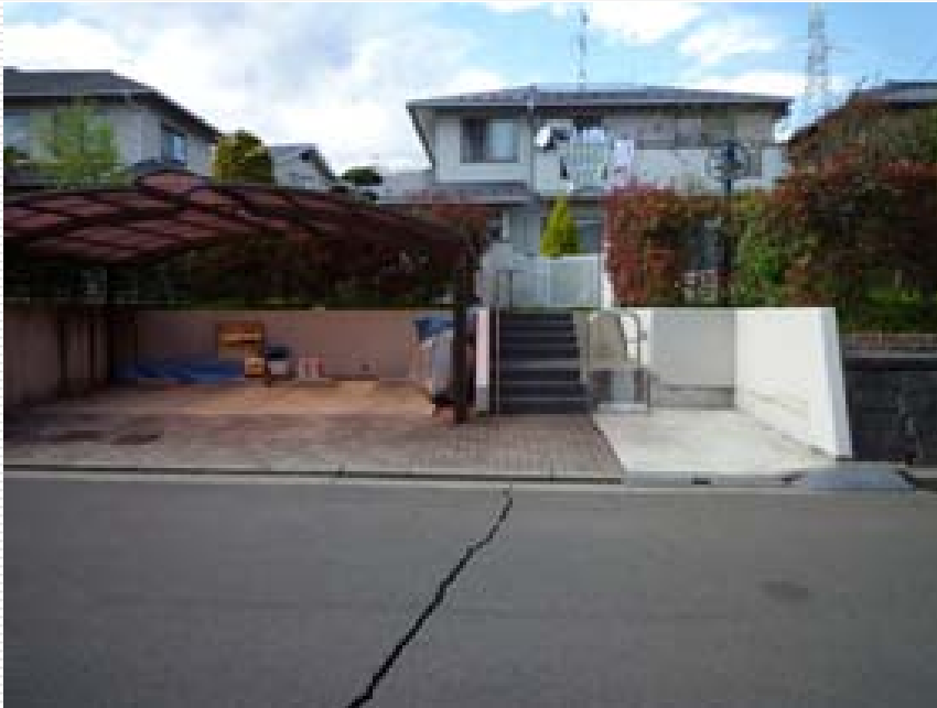
前面道路の亀裂
