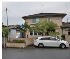
被害の大きかった益城町で、地震に耐えたツーバイフォー住宅。
