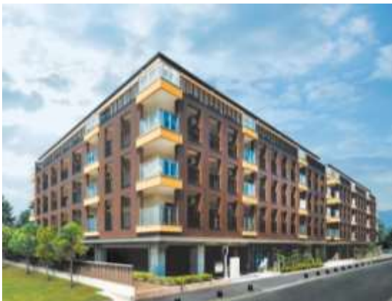
ツーバイフォー5階建て（1階RC） 特別養護老人ホーム （2016年，東京都）
