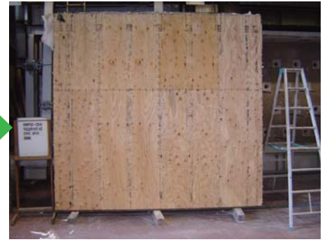
加熱後② 耐火被覆材を除去した後、構造躯体を確認したが炭化などの問題はない
