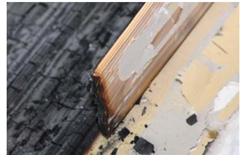
難燃処理されたスギをはがしてみると、燃え止まっており、その下のせっこうボードには影響が見られないことがわかる
