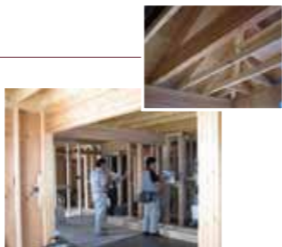
下地材等を取り除いて構造チェックを行い、安全性を確認したうえでリフォームが進められた。
