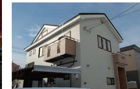
2階の全室にロフトを設置するため、壁を高くとり、勾配のゆるやかな屋根にかけかえられた。建物の高さがリフォーム前より約90cm高くなっている。
