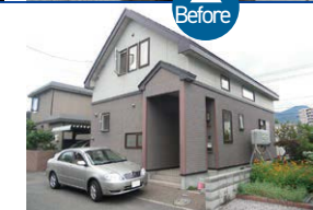
北側道路から見た外観。
