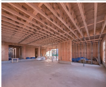
ツーバイフォー工法によるさまざまな施設系建築物の普及・拡大に取り組む
