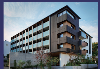
▲ 共同住宅(木造マンション)
