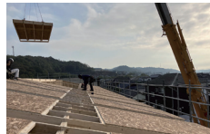
パネル施工基準合理化(屋根パネル施工風景)
