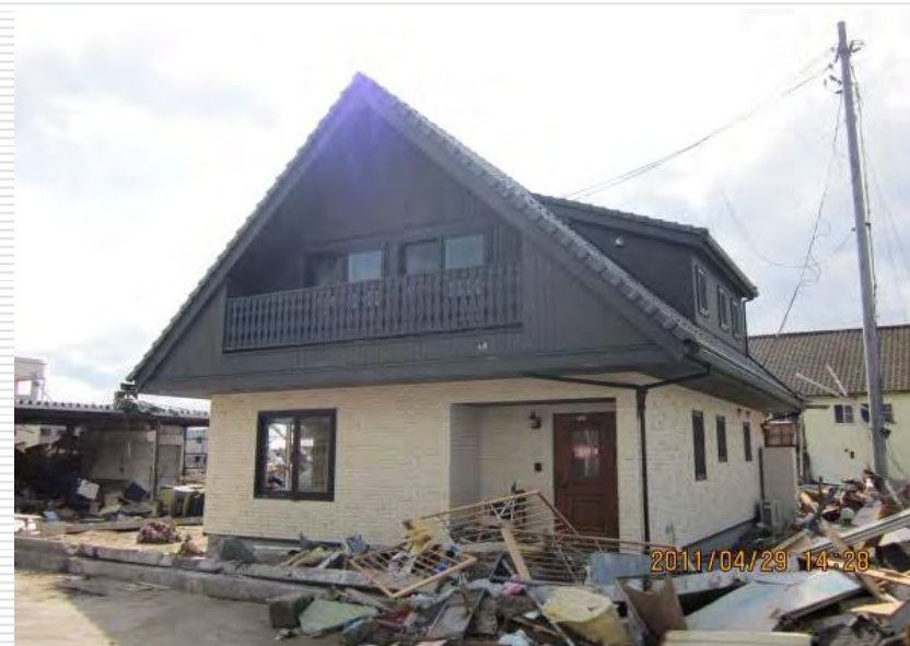
2階まで浸水。躯体の被害が少なかった住宅
