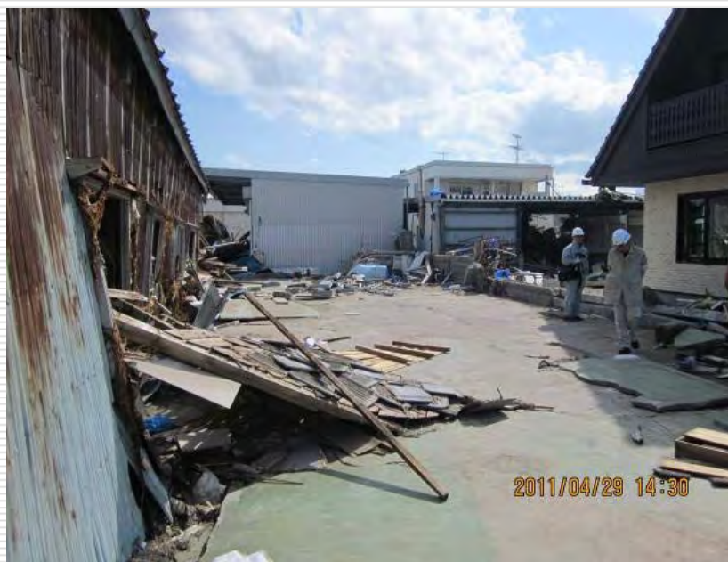
隣の工場は7m程建物上物が漂流
