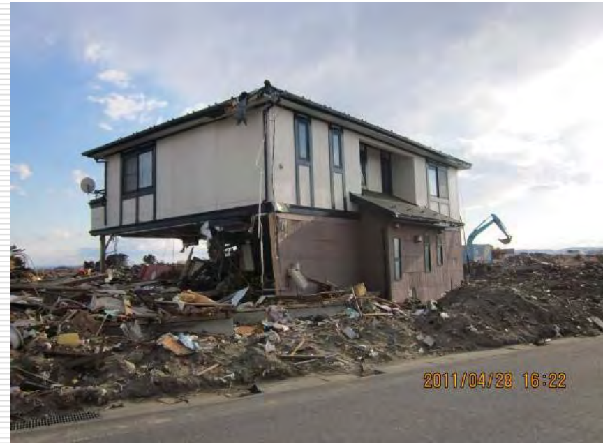
漂流物の被害でも自立した枠組壁工法住宅
