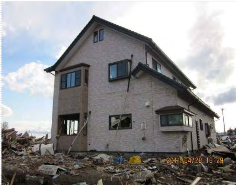
二階床上（3m超）まで浸水した木造住宅
