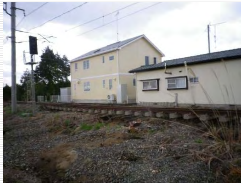
外観上被害なし 線路は崩壊
