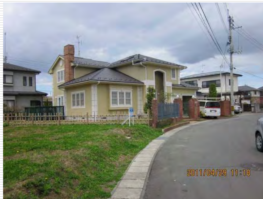
大きな吹き抜けのある建物だが被害なし
