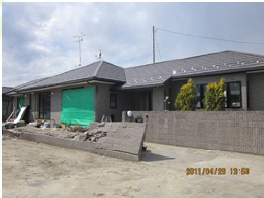
南面の掃き出し窓2箇所より海水侵入
