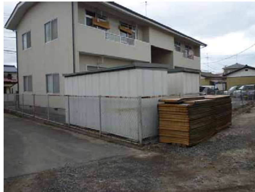
住宅 A-10 近隣での浸水痕跡。
