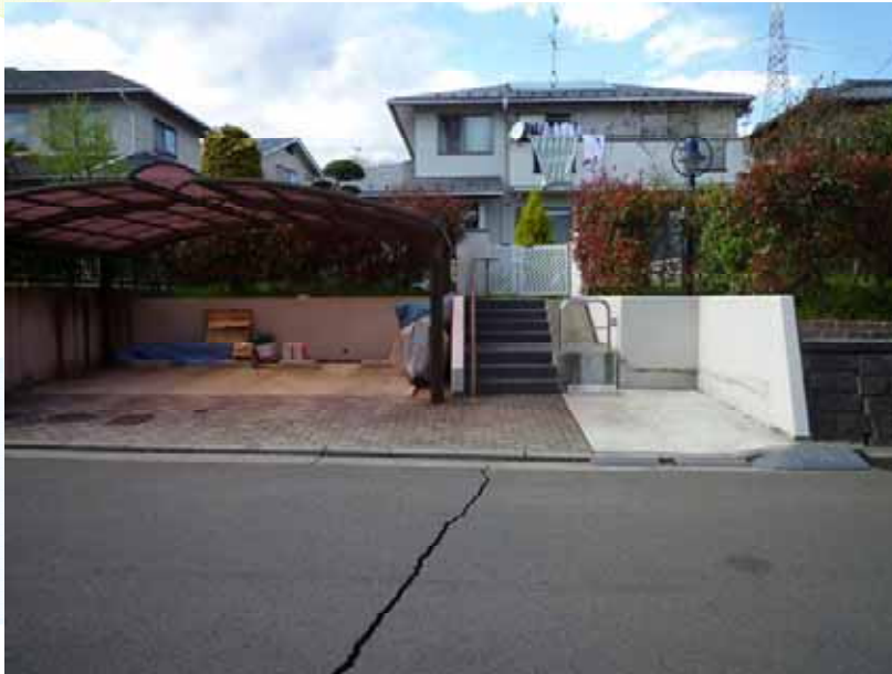
住宅 A-3 の外観。道路に亀裂あり。
