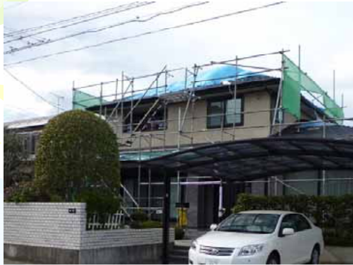
住宅 A-6 は屋根瓦の落下があった模様。足場を設置して工事中。
