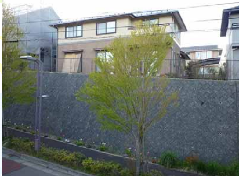
住宅 A-9 全景及び擁壁の状況。
