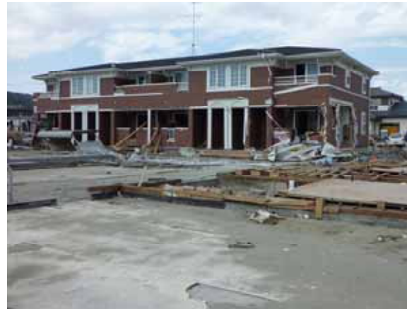
枠組壁工法による集合住宅の津波被害。
