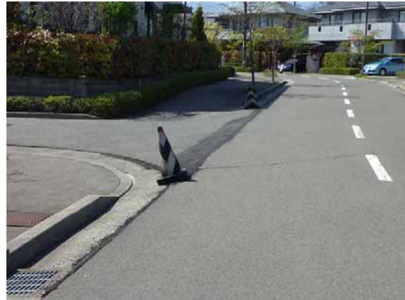
住宅 A-2 の全景。外観上損傷は認められない。住宅 A-2 に向かう道路の段差。
