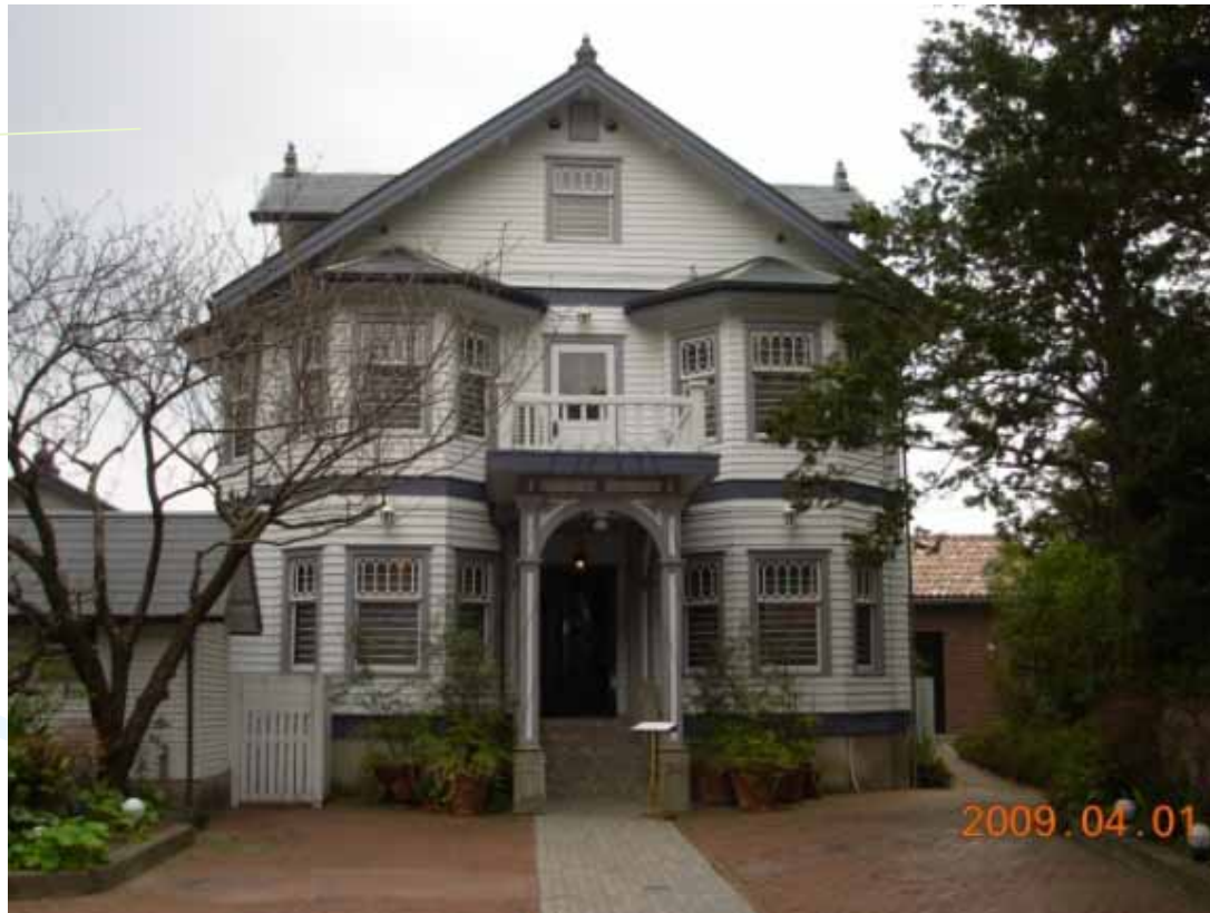
大正元年新築 現存する最古のツーバイフォー小屋裏3階建て洋館(大磯駅前)
