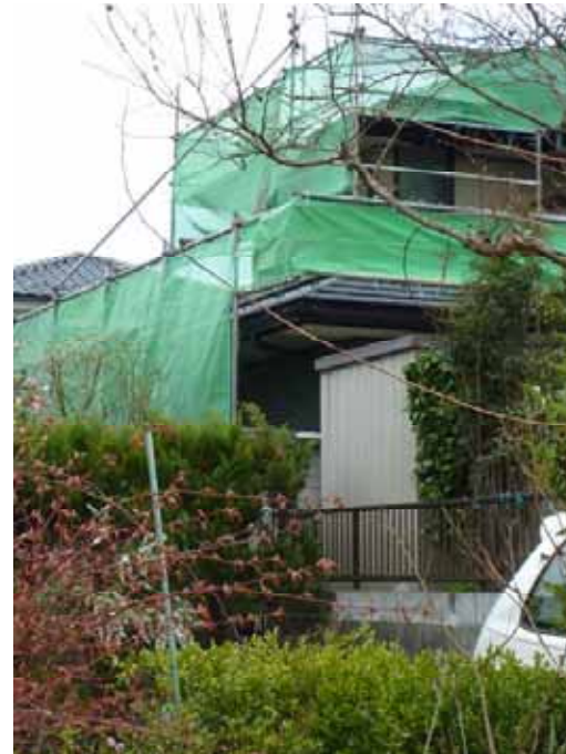
住宅 A-6 背面の状況。高さ 1m 程度の擁壁となっている。
