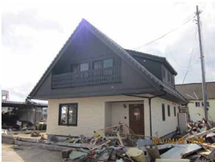
浸水はしたものの 躯体への被害が殆ど無かった2×4工法住宅
