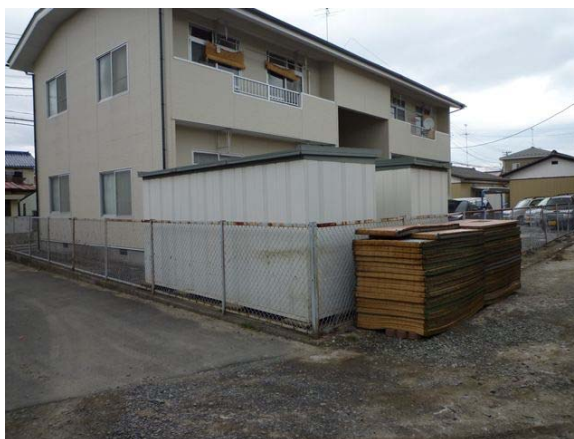
調査事例 2A-1 の近隣での浸水痕跡。
