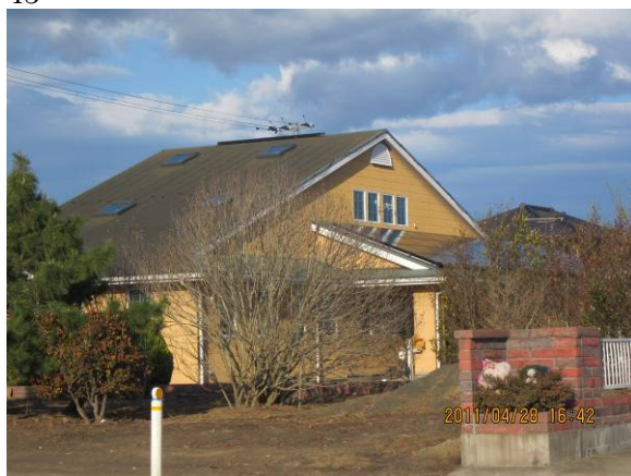
外観上は問題なし（2×4 建物）
