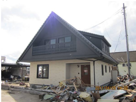
浸水はしたものの、躯体への被害が殆ど無かった 2×4 工法住宅
