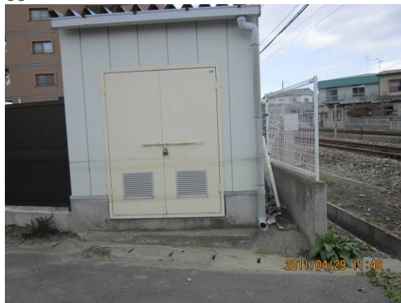
写真 64 近く。跡から約 1m の浸水と思われる
