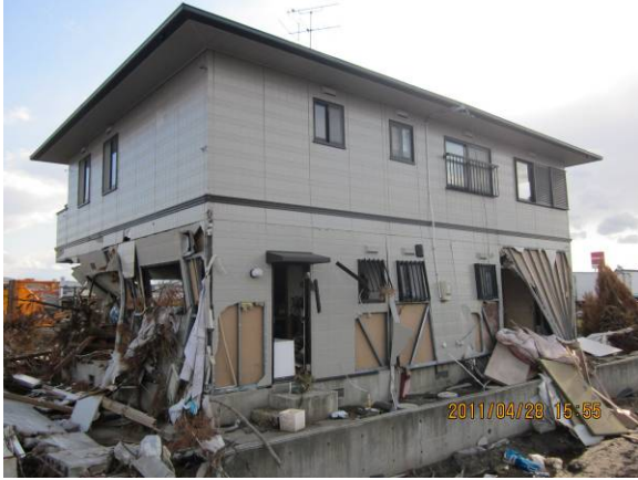
1階が津波被害を受けた鉄骨系の住宅。住宅の中で津波の流れ方が見て分かる。
