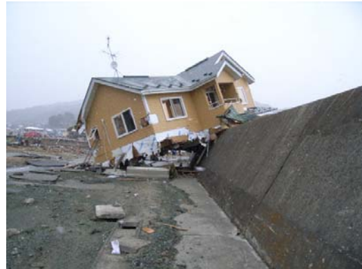
流出した2階部分
