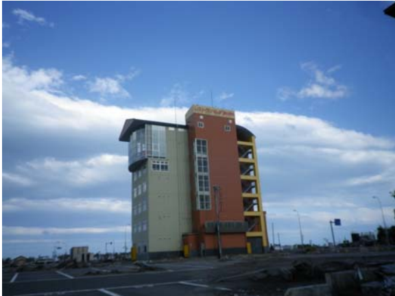
付近のS造建物
