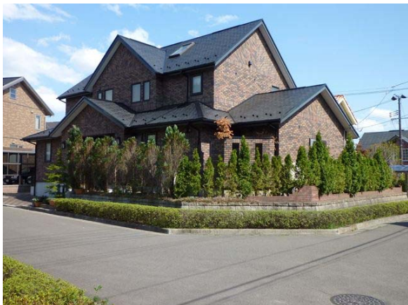
全景。外観上損傷は認められない。
