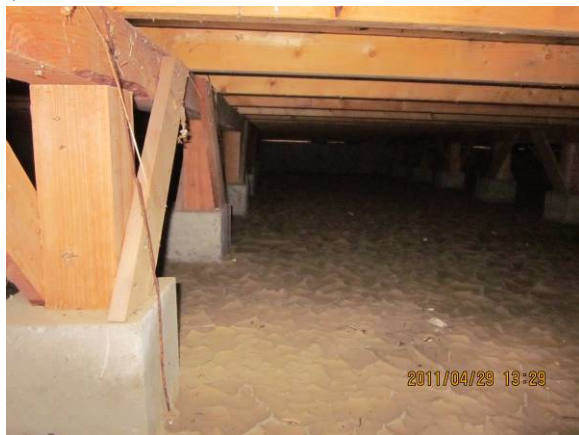
床下の様子。底盤は泥で見えない。以外に汚泥少ない（猫土台影響？）
