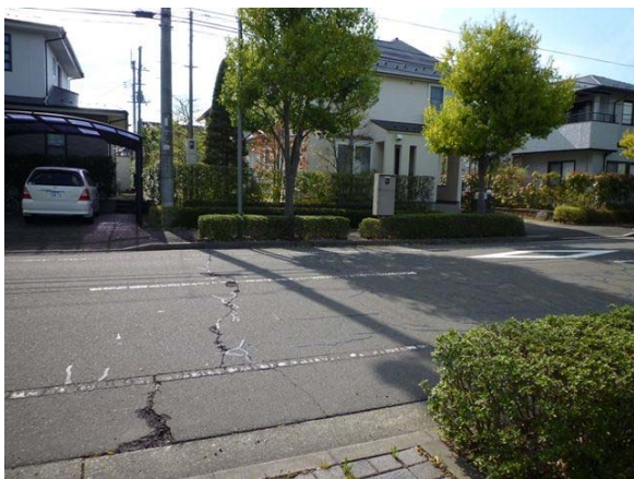
調査事例 1A-5 の前面道路に生じた亀裂。
