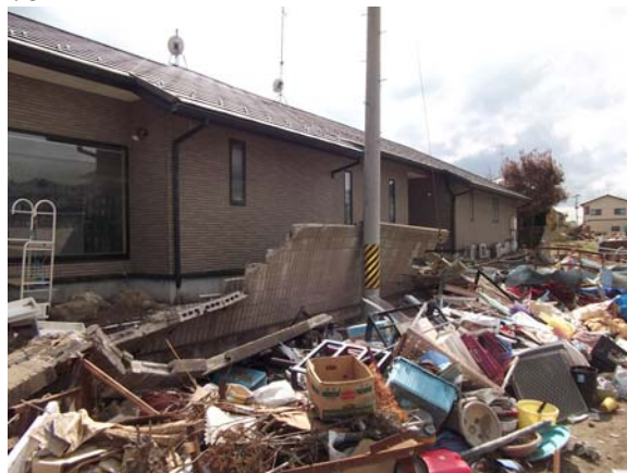
裏側（海から遠い側）の塀は建物との間に回りこんだ水の圧力で傾くとともに、塀の外側の脚部が水により搦り取られるような現象により脚部から倒壊したものと推察される。
