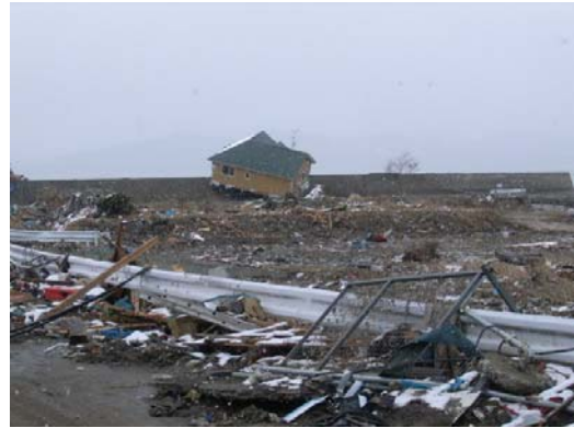
敷地から500~600mほど離れた防波堤まで流出した2階部分
