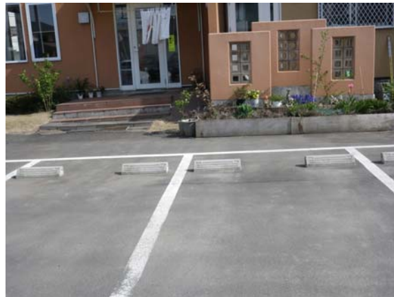
調査事例 1B-2 の近隣；地盤の隆起。
