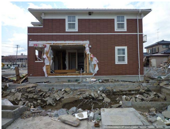
妻面の開口部の損傷状況。
