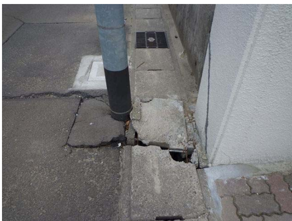
調査事例 1A-7 の前面の電柱脚部。
