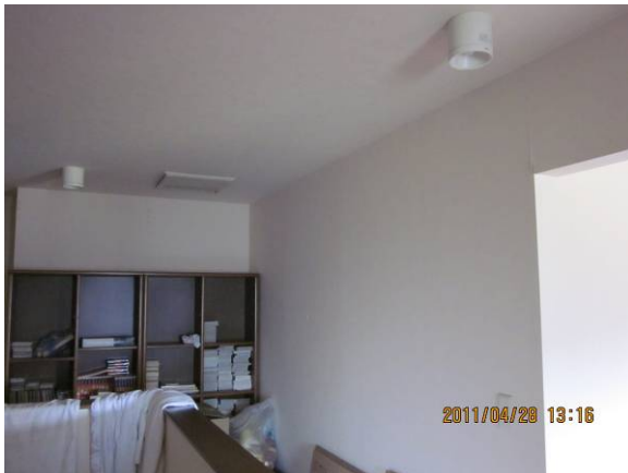
2F の内壁にクラック等はあまり見られない
