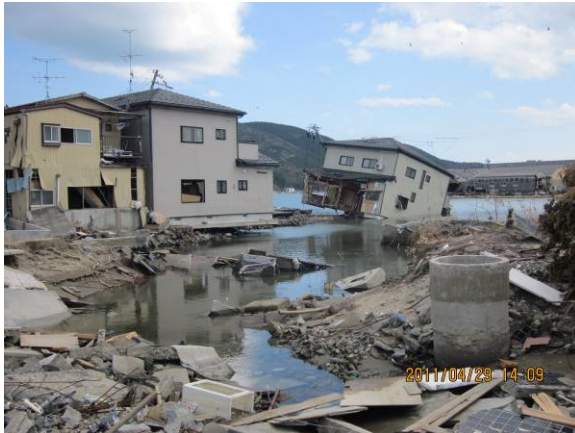
海近くの被害状況
