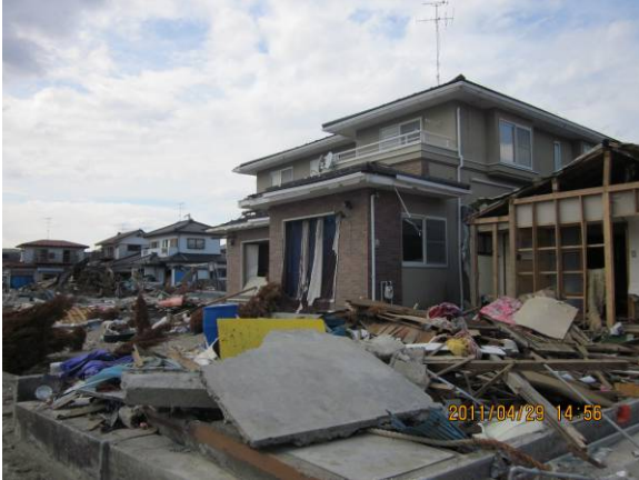
写真 80 付近。残るツーバイフォー工法
