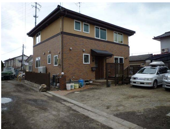
外観。特に被害は見当たらない
