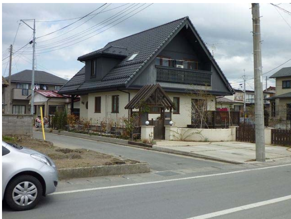
外観からは特に被害は見当たらない
