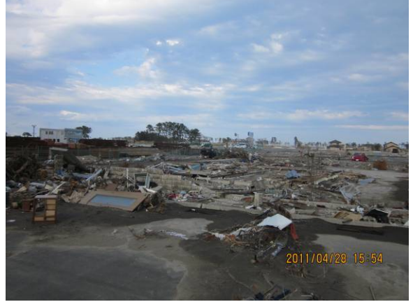
津波で流され基礎しか残っていない建物跡も
