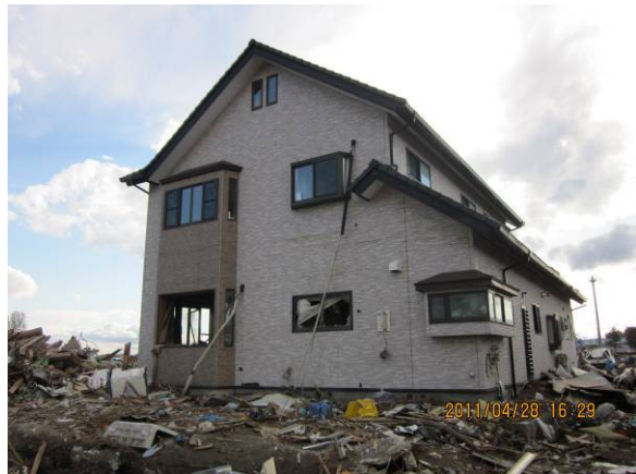
2階床上（3m超？）まで浸水している
