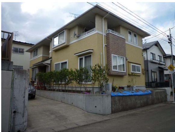
全景。外観上大きな被害は認められない
