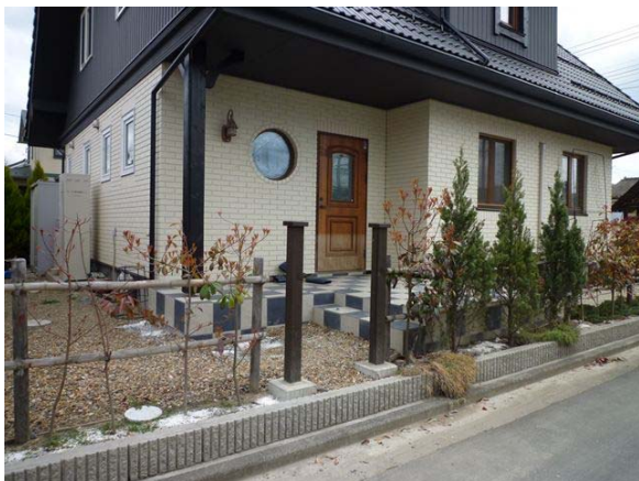
調査事例 2A-2 の玄関扉に残る浸水痕跡。
