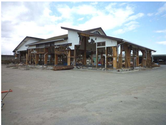
集成材による工場建築物残存状況。
