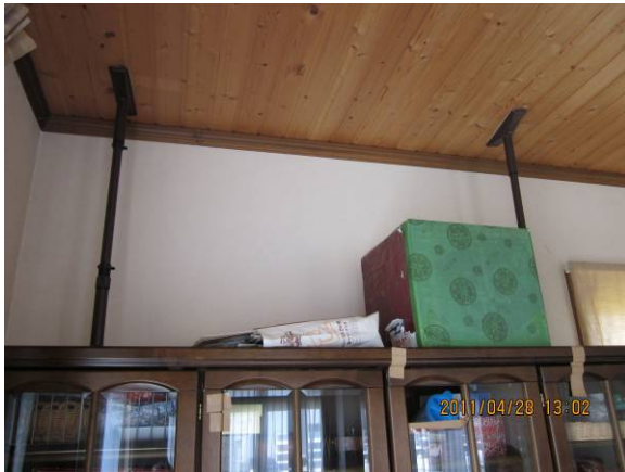
ガラス戸棚の上部つかえ棒が 0311 本震の際は効いたが、2 回目の時は効かずに戸棚が倒れた。
