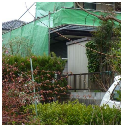
背面の状況。高さ 1m 程の擁壁となっている。
