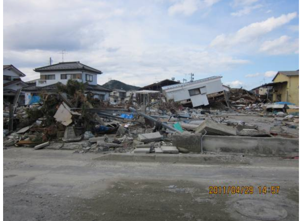
倒壊している住家
