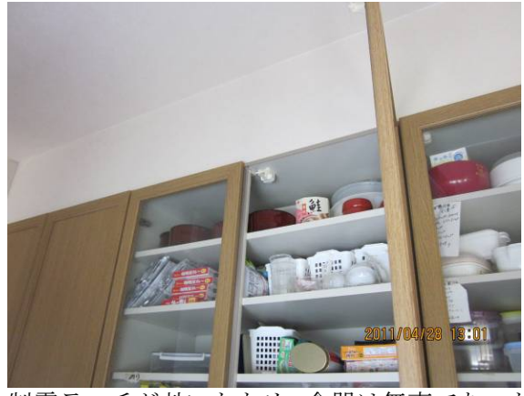
制震ラッチが効いたため、食器は無事であった
