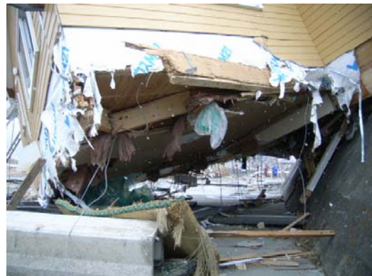
流出した2階部分の損傷状況
