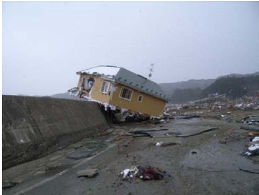
流出した2階部分
