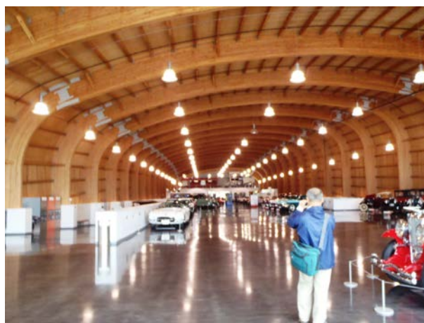
写真7 左:ルメイ自動車博物館 2012年開館 右:集成材アーチ架構スパン30m 野地28mm合板
