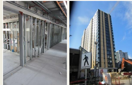
4 階 UBC 学生寮（バンクーバー） 18 階建て（1 階 RC） 柱集成材、床 CLT、EV 壁 RC
