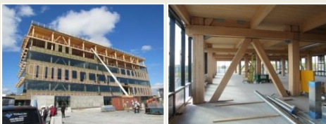
SYNERGIA プロジェクト（モントリオール） 6 階建て事務所 柱・梁・床集成材、壁 CLT
