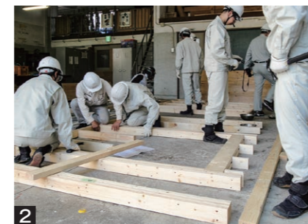
2 1日目につくった床の上に壁を起こし、固定していく。
