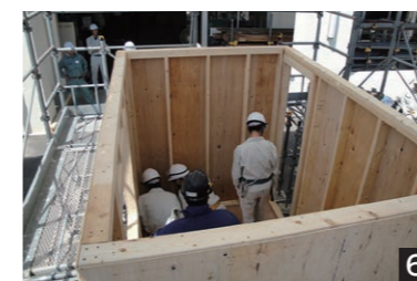
6 規定通りに仕上げた4面の壁がぴったりとおさまった。
