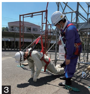
3 足場業者から最新の安全基準についての説明を受けた。フルハーネスは安全ベルトより体にかかる負担が少ないことを実感する。
