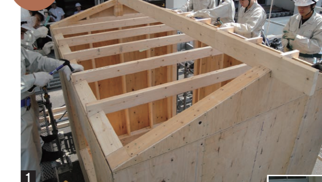
1 最終日は、足場にのぼり屋根をつくる。炎天下で、初日の安全実習を思い出しながら、命綱をかけ気を引き締めて作業に取り掛かる。
