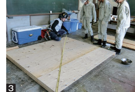
3 ツーバイフォーの構造の基本となる壁の製作は、正確さが要。面材張りでは都度寸法と直角を確かめ、歪んでいると何度もやり直しをする。
