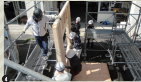
4 出来上がった壁版を床版の上に起こして、釘でしっかりと固定していく。
