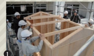
1 壁版に天井根太を固定。安全帯をつけて高所作業に取りかかる。
