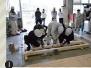
1 ツーバイフォーの基本となる壁版の製作は枠組材の組み立てから。講師陣は技術面・安全面に配慮して指導。
