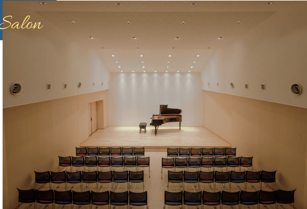
横幅8.3m、縦幅13.2m、天井高5.3mという大空間のコンサートホール。約100座席のお客様を魅了する遮音・音響設計を施している。床や壁、天井にグラスウール、プラスターボード、合板を用いて多層にし遮音性を高めている。音響の点では、四面を2重壁にするともに、ステージの左右の壁と天井は開くように角度をつけて、反射した音が客席に向かう仕組みに。一方、客席の後ろは聴きやすい音になるように、調整の役目を果たす吸音材を施している。ステージに常設のスタインウェイB型と通常は控室に置いてあるヤマハS6B型を対面させて置き、2台ピアノDUOに対応できる。
