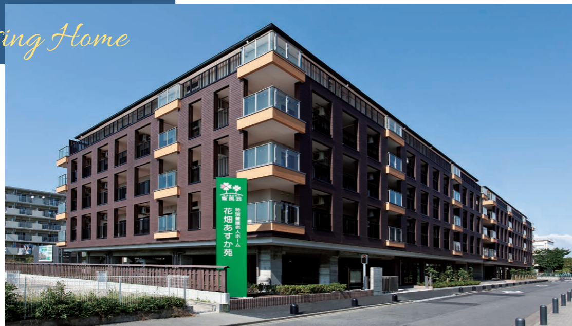
特別養護老人ホーム「花畑あすか苑」は、都用地を活用する足立区の福祉インフラ整備事業の公募を経て、16法人の中から選定された社会福祉法人聖風会により、平成28年8月開設された。ツーバイフォー工法では国内最大の規模となる延床面積9,000㎡超の5階建て（1階部分は鉄筋コンクリート造）である。
