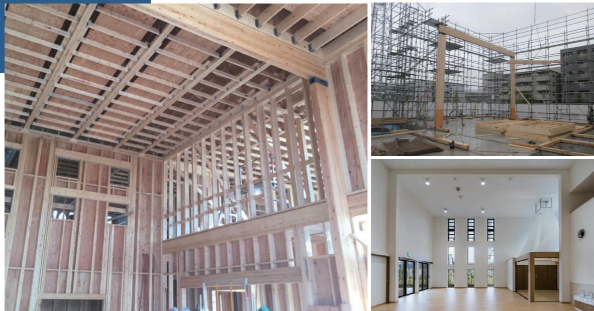
地盤への対応や大空間の確保という課題をクリアしたツーバイフォー工法による保育園。地盤対策には、地盤改良層と基礎を一体化させる工法を採用した。遊戯会などに必要となる大きな空間は、「木質門型ラーメンフレーム」を採用して天井高5.9mの吹抜け大空間をつくりだすことができた。コーナーの休憩室はキャンパス地による吊天井とした。
