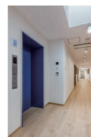
2階のエレベーターの上がり口を大きく設けた。天井には排煙窓を設置している。
