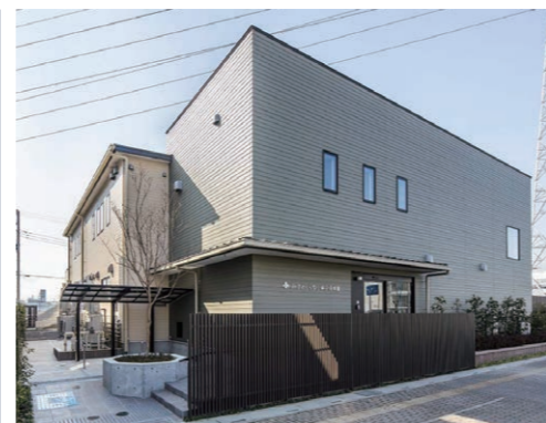
北側にある保育園の出入り口。南北の両側が道路に面し、南側には学童保育室の出入り口がある。ベビーカーが使えるようにスロープを設けている。
