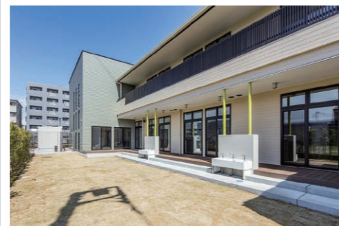
園児たちが元気に遊ぶことができる園庭。建物に囲われた設計になっている。底のあるテラスやバルコニーが設けられているので、夏は西日を遮断し、冬は暖かい日差しを採り入れることができる。
