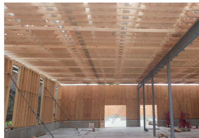
仕込室の工事中写真。奥から右手前に伸びる鉄骨架構は、屋根の中間支持を担う。斜め材は施工中の壁を支える「パイサポート」。
