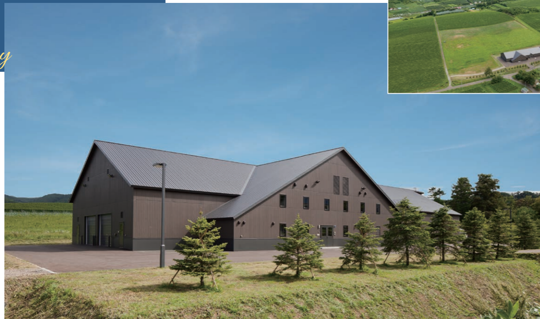
多雪地域のため積雪荷重を考慮して屋根勾配を5.5寸として建てられた。外観デザインの特徴となっている正面の切妻の大屋根部分が2階建てのほか、全長65mの工場スペースは4~5mの高天井が確保されている。北緯43度、眼下に日本海を望み、三方を山に囲まれた余市町登地区は、南北に真っすぐ貫く川が開いた谷状の地形で、ワイン用ぶどう栽培の適地として注目されている。
