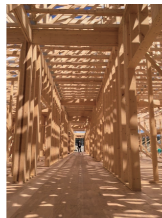
3.3mと長く製材したスタッド材を使用することにより、天井裏に空調設備を据え付けただけで、天井の高い開放的な空間が実現した。
