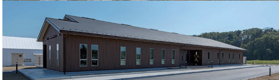
特別名勝松島保護地区に指定された景勝地であるため、外観上の規制が考慮され、屋根を切妻の大屋根とし、外壁には木調サイディングが使われている。その大屋根に採用されたトラス構造により大スパンを飛ばすことが可能になった。18m×10mの広さがある休憩ゾーンにはシザーストラスが用いられ、勾配天井&無柱空間が実現した。
