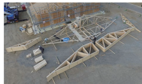
輸送に配慮して現地で組み立てるユニットトラス工法が採用された。妻側のスペースを活用することで組立作業とクレーン作業が効率よく進んだ。
