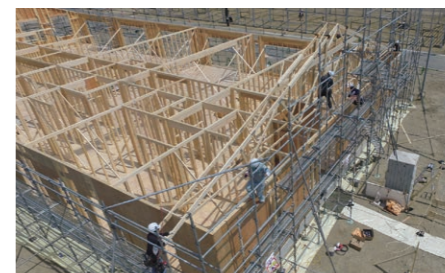
2枚を並列に接合してからクレーンで上げられたトラスは、風にあおられないように両端を支持しながら固定される。
