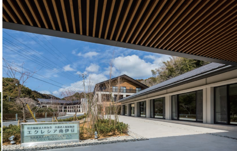
複合介護施設「エクレシア南伊豆」のエントランス。木造であることにこだわり、右手前の棟の1階とエレベーター棟以外はツーバイフォーの耐火構造で建てられた。
