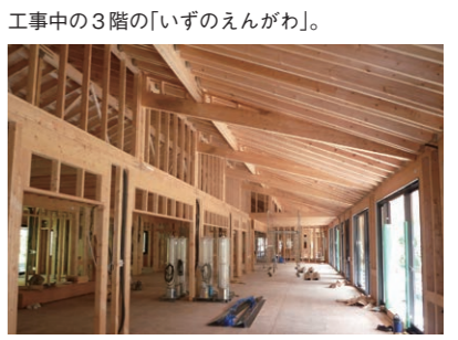
大空間が求められるデイサービス上部には平行弦床トラスとLVL梁が採用されている。
