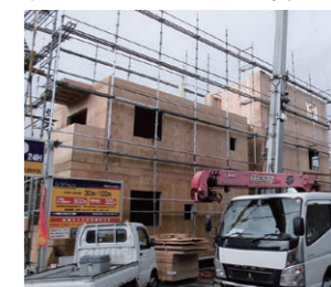
小型クレーンによる施工風景。
