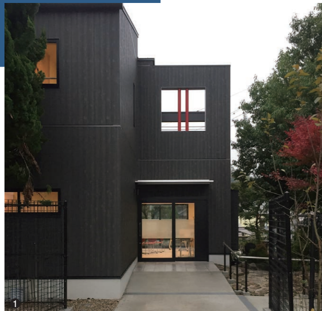
①エントランスドアのガラス戸越しにロビー&ラウンジが見える。2階にも開口があり、視線が抜ける。庇は鉄骨の屋外階段とテイストの合うアルミ製のものが採用された。②林を背後に控え、自生植物が生い茂る自然豊かな環境に建つ新校舎。左奥に見える建物が本校舎。手前が狹隘道路のため、工法選定においては施工面でもツーバイフォー工法が優位だった。③構造体の写真。2階床に平行弦トラスが施工されている。
