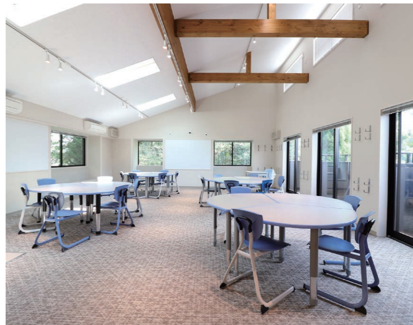
2階の教室。約60m 2 の広さがある。木質断熱複合パネルが採用され、勾配天井が設けられた。木造建築を感じてもらいたいという意図から集成材の構造梁が現わしとなっている。
