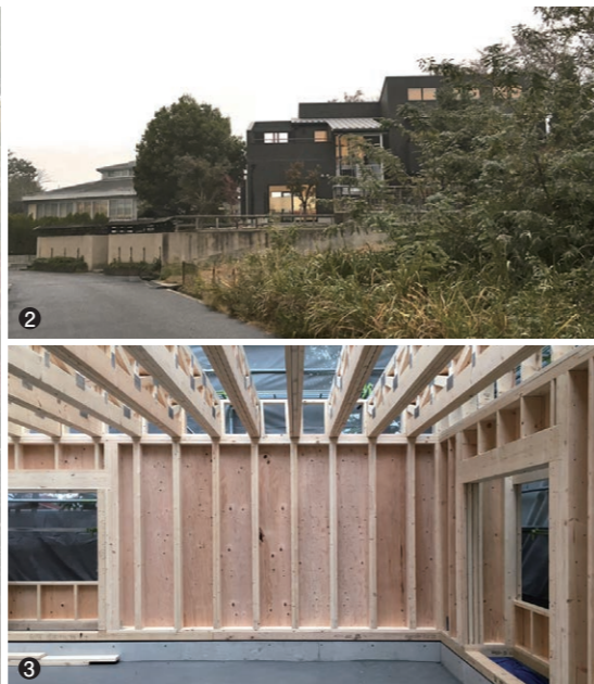
①エントランスドアのガラス戸越しにロビー&ラウンジが見える。2階にも開口があり、視線が抜ける。庇は鉄骨の屋外階段とテイストの合うアルミ製のものが採用された。②林を背後に控え、自生植物が生い茂る自然豊かな環境に建つ新校舎。左奥に見える建物が本校舎。手前が狹隘道路のため、工法選定においては施工面でもツーバイフォー工法が優位だった。③構造体の写真。2階床に平行弦トラスが施工されている。
