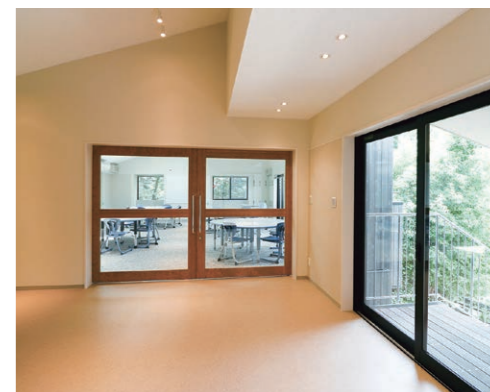
ロビー&ラウンジも教室の一部として使えるように、全開放できる大きなガラス窓の引き分け戸が設けられた。戸を閉めていても視線が抜ける。
