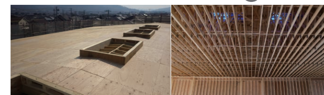
野地板の施工/トップライト取付け用の下地もパネル化して搬入、施工。
