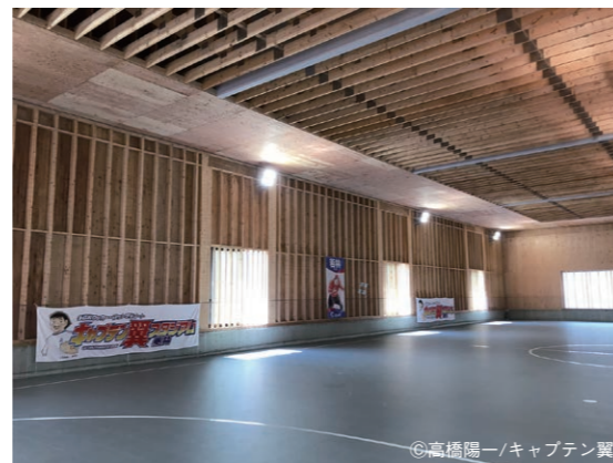
屋内フットサルコートは21m×40mの大空間。内部は構造体の現しで、窓やトップライトから自然光を取り入れている。下弦材の間に照明器具が設置されている。
