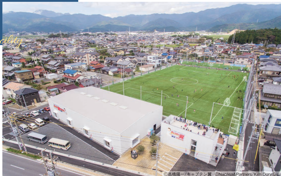
「垂井をサッカーの街に」という夢を掲げる地元企業により、全国に8カ所ある系列スタジアムのなかでも規模が大きく、独自性の高い整備が行われた「キャプテン翼スタジアム 垂井」。手前左側の建物が屋内フットサルコート、右手が更衣室、カフェ等を備えたクラブハウス。「木造のスポーツ施設は、山に囲まれたこの地域になじむ質感になっている」と設計者は語る。クラブハウスの屋上テラスは1階上と2階上にあり、奥のサッカーコートを一望できる。2階のカフェへは屋上テラスから入る設計になっている。
