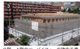
2 2階～4階のツーバイフォーの建方工事。外装工事。
