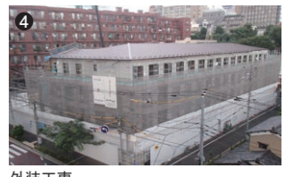
2 2階～4階のツーバイフォーの建方工事。外装工事。
