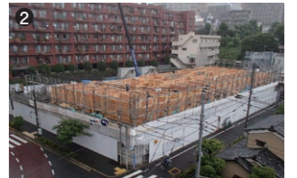
1 地階・1階の躯体工事終了後、ツーバイフォーの建方工事が始まった。
