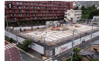
1 地階・1階の躯体工事終了後、ツーバイフォーの建方工事が始まった。
