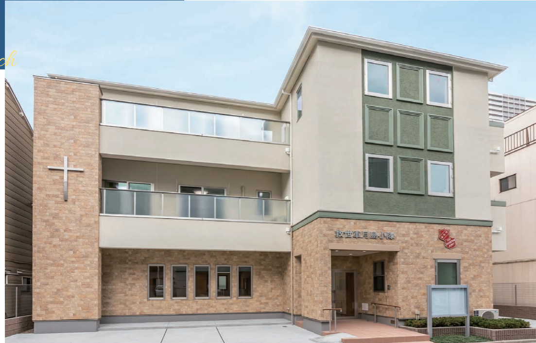
ツーバイフォー耐火構造による1階が教会、2階・3階が宿舎の複合施設。ネイルプレートトラスを3層に使用し、1階に大空間を確保した。「近隣になじむ親しみやすい建物を、という要望を受け、伝統的な洋館をイメージさせるデザインとしました」と設計者。大型トラックが現場まで進入できない道路条件のため、トラスは100mほど先から人力で搬入し、小型クレーンで揚重を行った。
