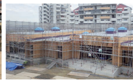
約5,000㎡の整形の敷地に建つ園舎は、ツーバイフォー工法による北棟と南棟が鉄骨造の円形の中央棟で結ばれたコの字型の建物で、隣接する公園につながるように園庭が確保されている。低層建築物であるが遠景からもシンボリックであり、見る方向によりさまざまな表情をもつように、外観デザインはマル・サンカク・シカクの組み合わせで、白と黒のモノトーンを基調に青・赤・黄色が使われている。
