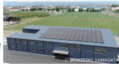
緩勾配の屋根に50kWhの太陽光発電パネルが設置されている。
