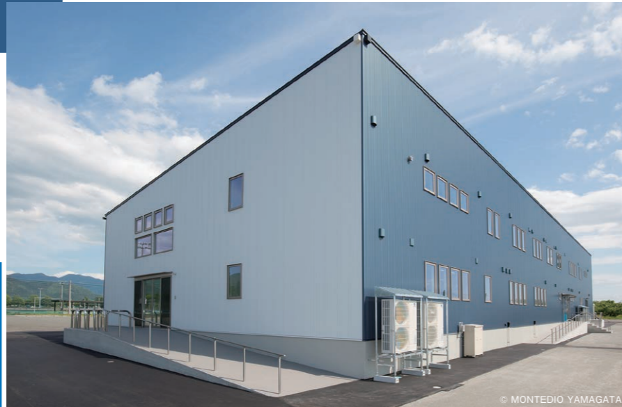
山形県総合運動公園内に建設された「モンテディオ山形」のクラブハウス。11個の住宅ユニットからなり、約1200㎡の規模がある。写真右手のブルーの壁側(西面)が練習グラウンドに面するメインファサード。左手の白い壁側(北面)に屋内トレーニングルームへ直接入室できる入り口が設けられている。
