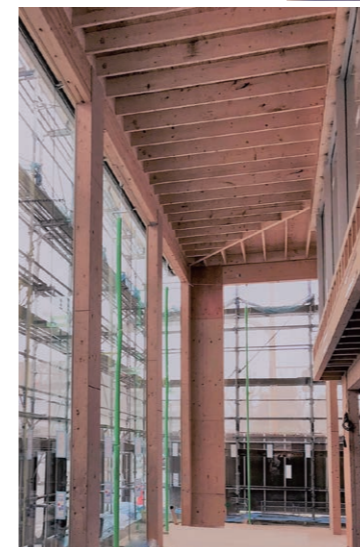
独自の木質門型ラーメンフレームを組み合わせることで、2階陸屋根までの大開口が確保された。
