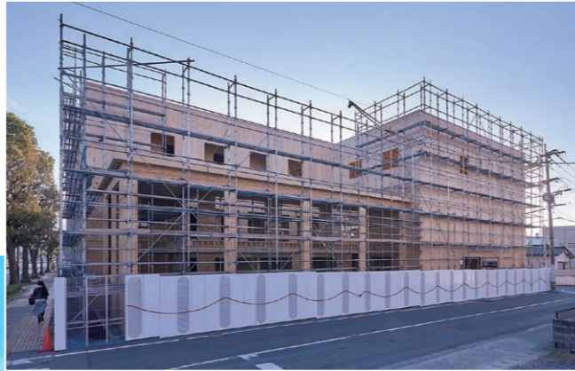
ロードサイドの商業施設を木造で実現。手前が木質門型ラーメンフレーム。
