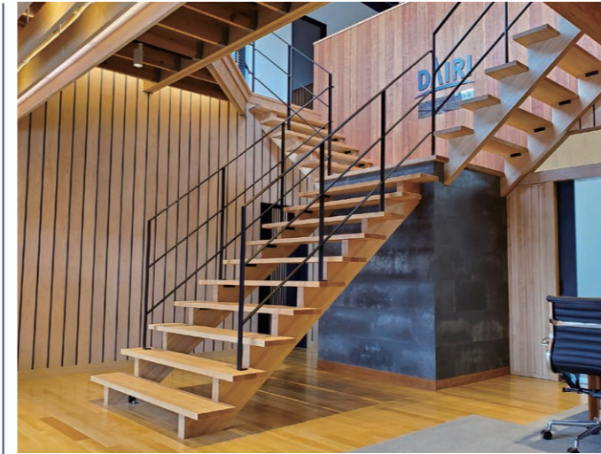
開放感と木の温もりが感じられるエントランスホール。蹴込みのない軽やかなデザインの階段をY字型に配置。
