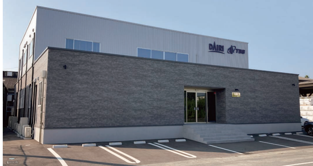
ツーバイフォー工法によって約4ヵ月と短工期で竣工した新社屋。合理性を重視し、シンプルな外観とした。
