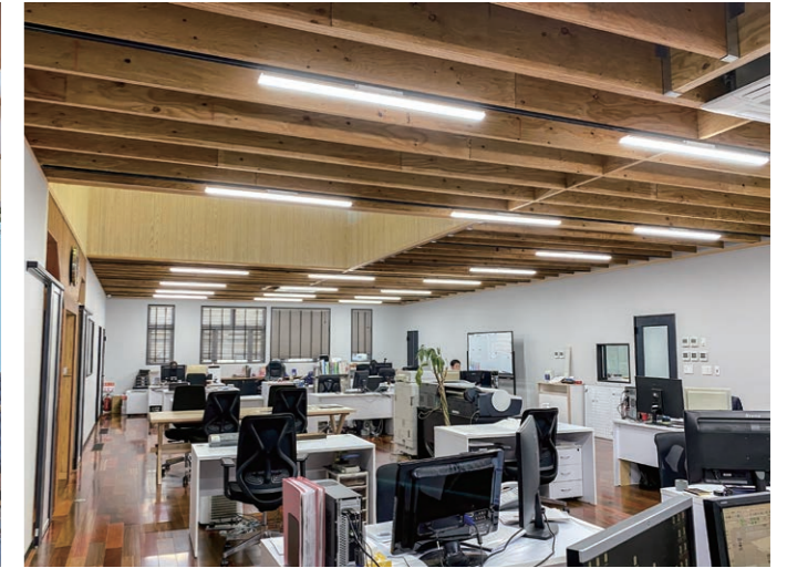
約19m×8mの大空間で、中央(左上)に約4m四方の吹抜けがある事務室。天井はLVL現し。全館蓄熱床暖房で、冷房のみ天井の空調を利用している。
