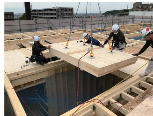
床版の一部にはツープайフォー製材を使った新構造材NLTが使われている。
