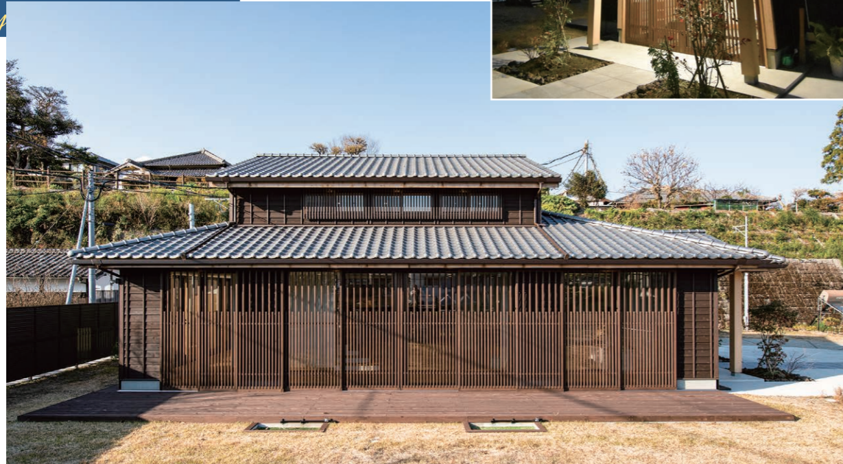
武家屋敷に倣った和風の外観。熊本地震をはじめ近年の自然災害による歴史的建造物の被害を鑑み、飩肥格子や下見板張り、日本瓦など伝統建築の意匠を継承しながら、基本性能が高く地震・台風等に強い建物をツーバイフォー工法で実現した。また、屋根遮熱通気工法など独自の技術を採用して宮崎の夏を快適に過ごすためのパッシブソーラーデザインが取り入れられている。
