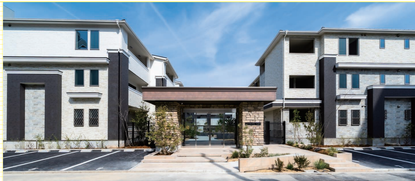
低層住宅が多い周辺環境を考慮し、約500坪の敷地に3棟の3階建て賃貸住宅を建設。メインゲートを設け、中庭を通過して各棟へと至る邸宅感を創出した。
