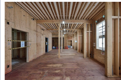
2階の手術室の床根太には集成材を使用。振動対策で短いスパンで配置されている。
