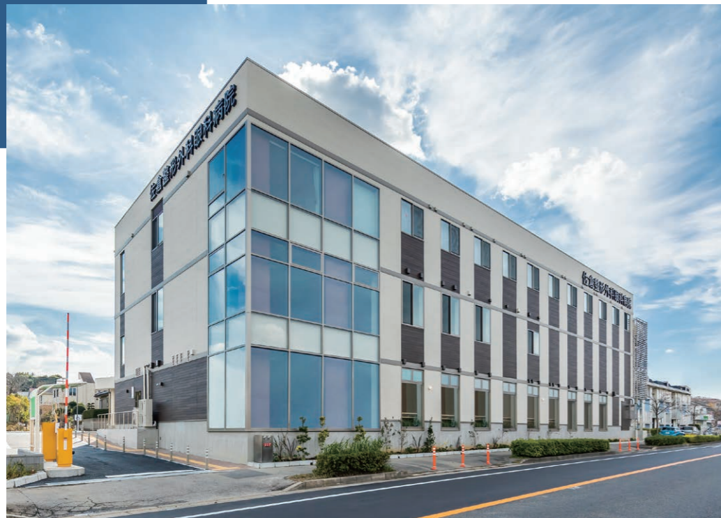
前面道路側のファサード面にカーテンウォールを採用した外観。ガラス張りの開口部をふんだんに用いることで、構造強度を確保しながら、周囲の街並みからもインパクトのあるシンプルかつモダンなデザインが実現した。
