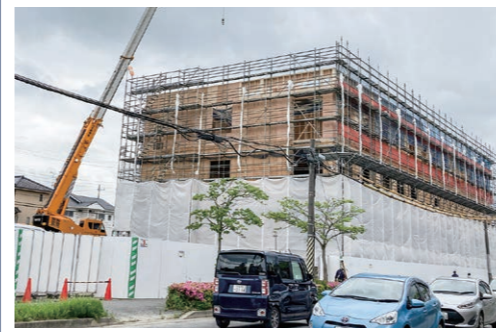
3階建ての病院をツーバイフォー工法による耐火構造で建設。
