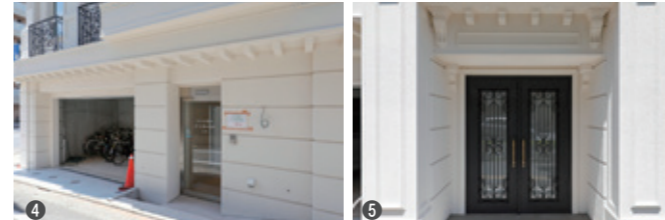
①②2階は歯科クリニック。広々とした高級感のある空間にデザインされた待合室(①)と、プライバシーを保ちつつ、院内の気配が感じられる半個室の診療室(②)。内装仕上げに一部国産ヒノキ材が使用されている。③3・4階は1LDK38.45㎡～51.20㎡の8戸で構成される賃貸住宅スペース。全室角部屋で、充実した設備と木を多用した流行に左右されない内装が特徴。④1階は歯科クリニックと賃貸住宅の駐車場・駐輪スペース。⑤正面中央には洋館の扉のような共用エントランスがある。
