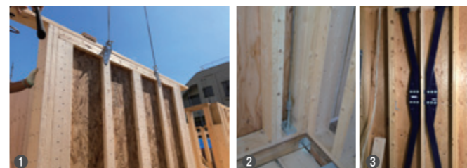
①耐力壁「ミッドブライ・ウォール・システム」。②PC鋼棒を用いた「タイダウンシステム」。③制震技術「VAX」。④木造耐火構造は1時間耐火の告示仕様が採用され、一般的な仕様となっている。
