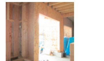
タイダウンシステムとLVLの柱による開口部の構造。
