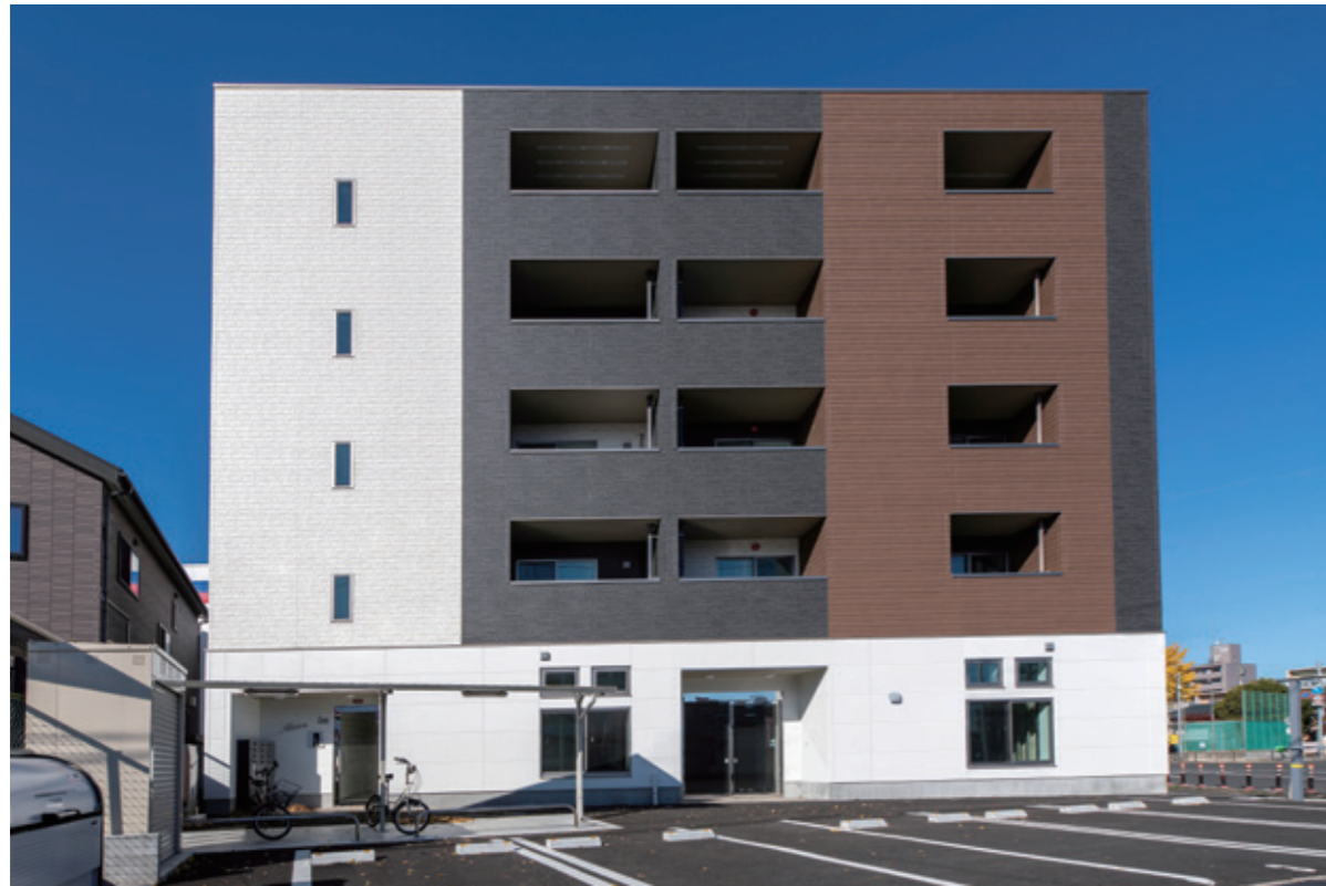
仙台の市街地に2023年5月に完成した共同住宅「アルバトロス」。「ないものを創りだす。」という企業姿勢のもと、「東北地方初の純木造の5階建て」を目指して計画された。白・石目調・木調の3色の外装材が張り分けられ、モダンな外観がデザインされた。
