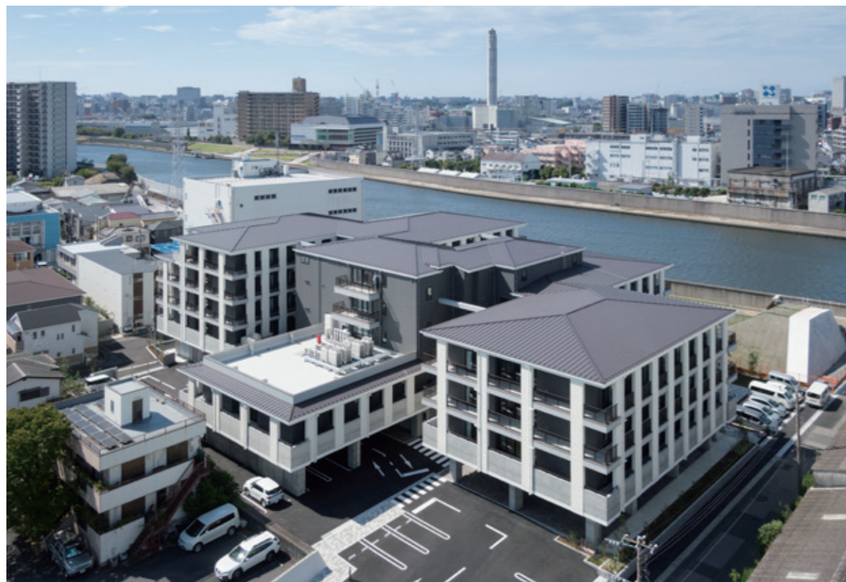
足立区の中学校跡地に建設。河川氾濫時に備えて1階RC部分の階高を通常より高く設計し、さらに平時は機能維持訓練に利用する5階の多目的ホールを2階入所者の避難場所とするなど安全確保の計画も練られている。「都市型中層木造建築として、木材を多用しながらあえて木造らしさを消した挑戦」と評価され、第5回COFI木造建築デザインアワードを受賞した。
