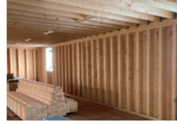
荷重の大きい部分には2×6材をダブルで配置。
