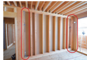
各層の引き抜き力はタイロッドを通じて直接基礎に伝達するため、各階の金物を小型化できる。
