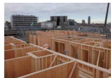
2～5階の4層はツーバイフォー1時間耐火構造。
