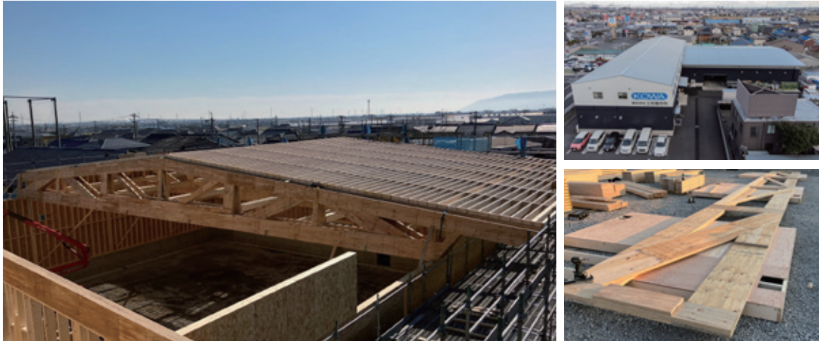
左：最大 25.4m のスパンを実現した LVL トラスの施工風景（平屋部分）。工期はウッドショックの最中だったが一般流通材を用い、設計段階から材料を手配して予定通りに竣工できた。右上：外観からは木造だとわからないが中の温熱環境は以前の工場とは歴然の差。冷暖房費用が大幅に抑えられ、従業員の方からも「信じられないほど快適で、仕事がしやすい」と好評。遮音性も高い。右下：LVL トラスは大型のため、現地で先行して作成された。
