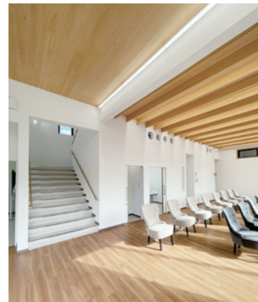
広々とした木質感豊かな待合ホール。天井にはCLTと化粧梁が組み合わされている。
