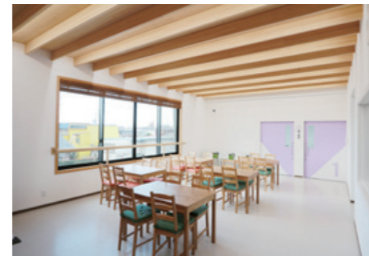
CLTを現しにし、化粧梁と組み合わせた自習コーナー。天井高は3.25m確保されている。
