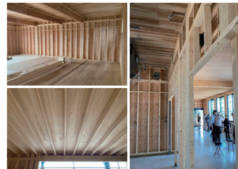
〈構造体の写真〉左上：2階の大教室。2階床版と屋根版にCLTが使われている。左下：現しとなる部分には節が少くない国産ヒノキ製造のCLTを採用した。右：2023年7月に開催した構造現場見学会は多くの人々が来場して話題となった。
