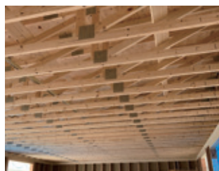
屋根にはネイルプレートトラスを採用。
