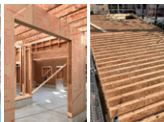
スタッドには「びわ湖材」を使用。2階床にI型ジョイストが採用された。
