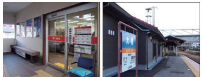
左：駅の待合室に郵便局の入り口がある。駅の改札口・待合室と郵便局とを仕切る壁のほかには構造的な壁や柱がない。右：ホームから見た駅舎。
