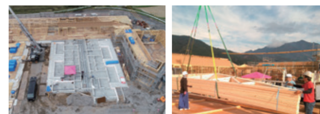
工事の様子。工期短縮のため3工区に分けて施工した。さらに、トラス工法を採用したことで工期短縮・コスト削減につながった。
