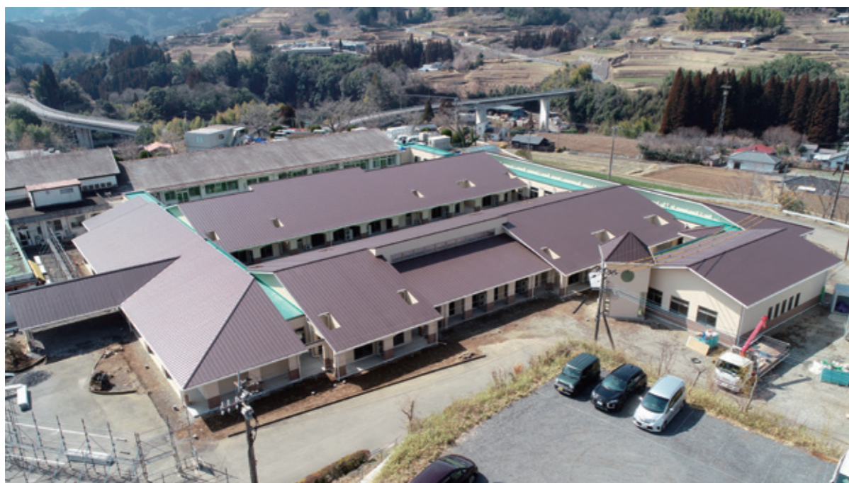
敷地の広さを活かして東西に細長い中庭を挟んで平屋の居住棟を配置し、そのまわりを執務スペースなどが取り囲むレイアウトとなっている。奥にある既存建物とは渡り廊下でつながり、スムーズに行き来できる。屋根の小開口は4人部屋の坪庭の位置を示す。
