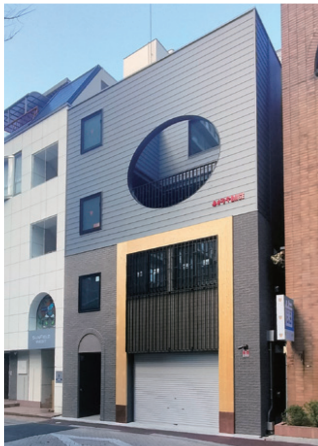
建物は、間口約8m、奥行き約24m、最高高さ13m。店舗が入る1・2階は通りに対して開き、3・4階は丸窓と吹抜けで外の様子が伝わる外観デザインとなっている。構造材供給と建方工事を行った組合のメンバーは「従来この立地であればRC造や鉄骨造の2択になるところ、木造が選択肢に加わったことは重要だと感じる」と声を揃える。
