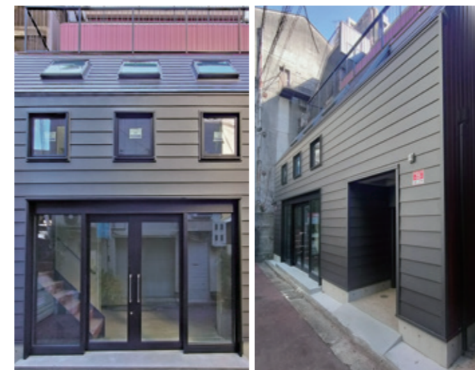
北面外観。飲食店のエントランス用に大きな開口部を設置。厳しい斜線制限により2階屋根から勾配が始まる。
