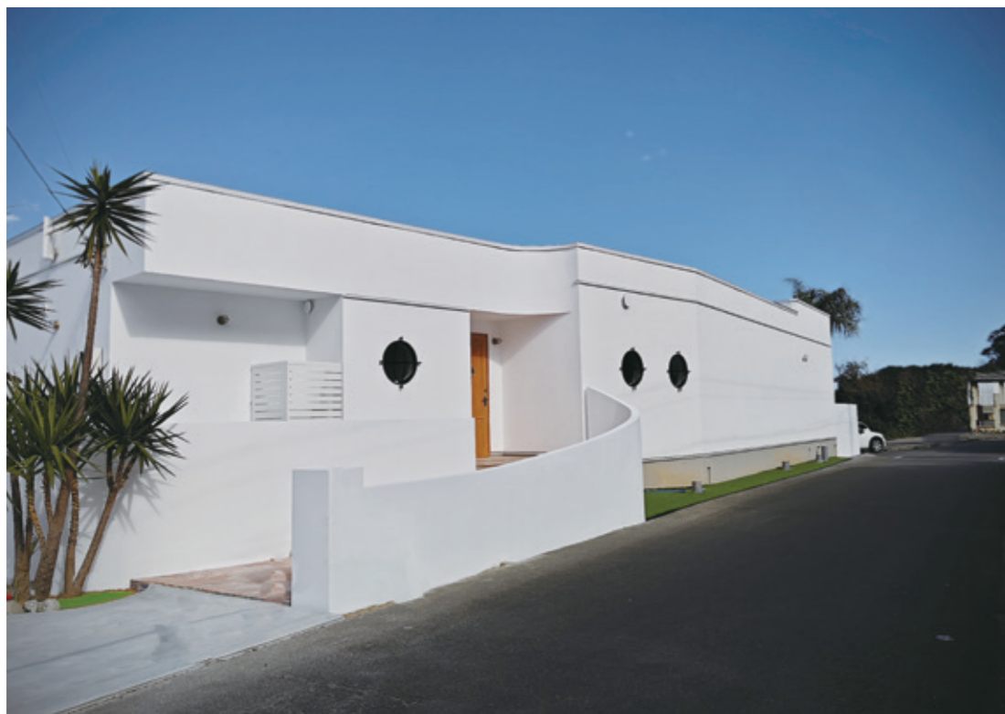
宮崎の青空に映える白をメインカラーに、アールを描く外構と一体化させた外観。内部に広がる開放感との対比を出すため、エントランスは船を模した丸窓以外はあえて閉じたデザインにした。
