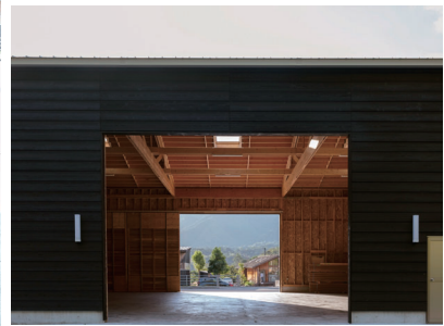
左: LVL トラス6本を用い、16.4 m × 33 mの無柱空間を確保。内部の平均高さは7.25m。大風や地震に遭っても、その影響を感じられないほど頑丈な建物となった。屋根に天窗が10か所あり、日中は電灯不要。右上: 山を背景にした景観に調和するようにデザインされた外観。屋根は2.5寸勾配でガルバリウム鋼板葺き、外壁は年月とともに風合いが増す焼杉の横張り。右下: 開口部は横6 m × 縦5 mの片引き吊戸で、開け放つと木構造が現しになった内部空間が広がる。
