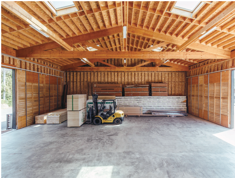
左: LVL トラス6本を用い、16.4 m × 33 mの無柱空間を確保。内部の平均高さは7.25m。大風や地震に遭っても、その影響を感じられないほど頑丈な建物となった。屋根に天窗が10か所あり、日中は電灯不要。右上: 山を背景にした景観に調和するようにデザインされた外観。屋根は2.5寸勾配でガルバリウム鋼板葺き、外壁は年月とともに風合いが増す焼杉の横張り。右下: 開口部は横6 m × 縦5 mの片引き吊戸で、開け放つと木構造が現しになった内部空間が広がる。
