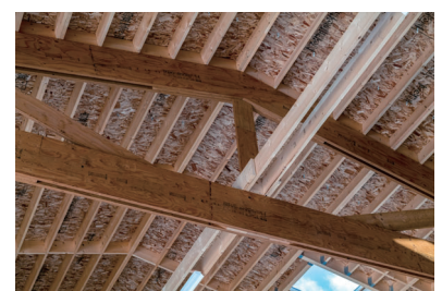
LVL トラスの上に横方向に210 垂木を架けている。
