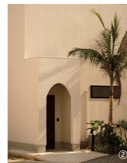
アプローチ部分。外壁は角をアールにするため、サイディングではなく、塗り壁仕上げとした。
