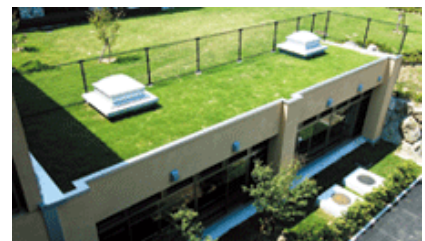
▲省エネと環境への配慮から地下・歩行浴槽の屋根は緑化
