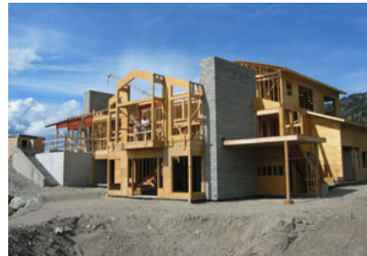
▲建築中の建物
