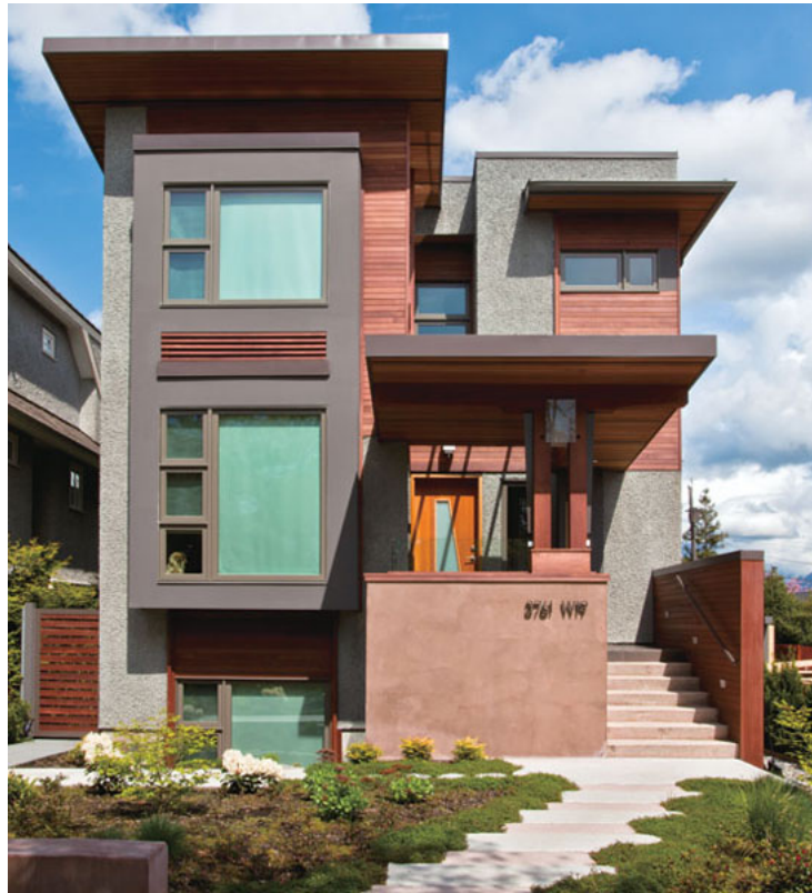
▲ルーフラットと深い軒や庇、突出させた1階と2階の窓が特徴の半地下付き2階建て住宅。
